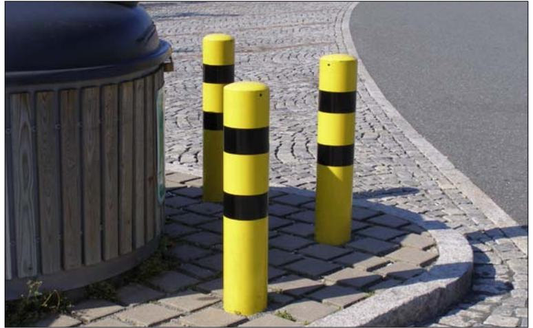
Rammschutzpoller ortsfest zum Einbetonieren
