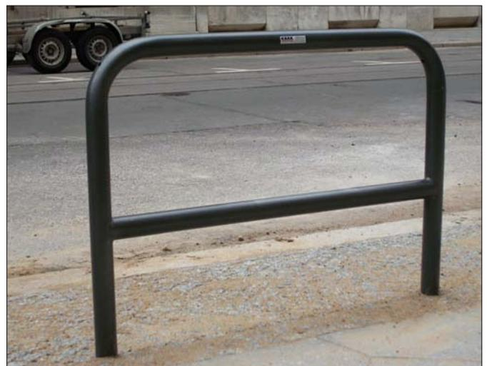
Anlehnbügel Typ „Standard“, mit Mittelstrebe in DB 703, Rohrdurchmesser 60 mm
